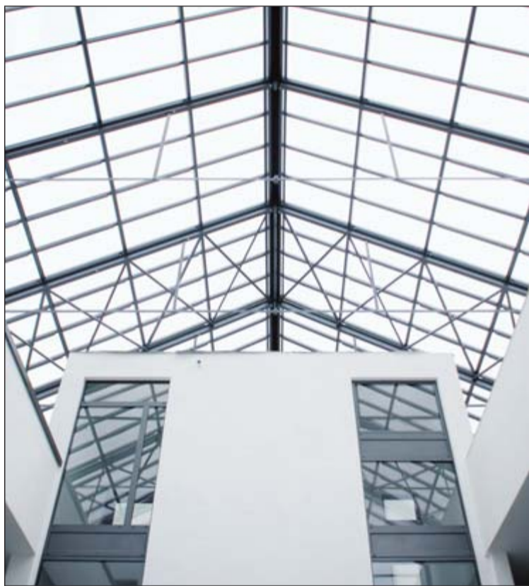
Das Atrium: lichtdurchflutet mit freiem Blick in den Himmel.
