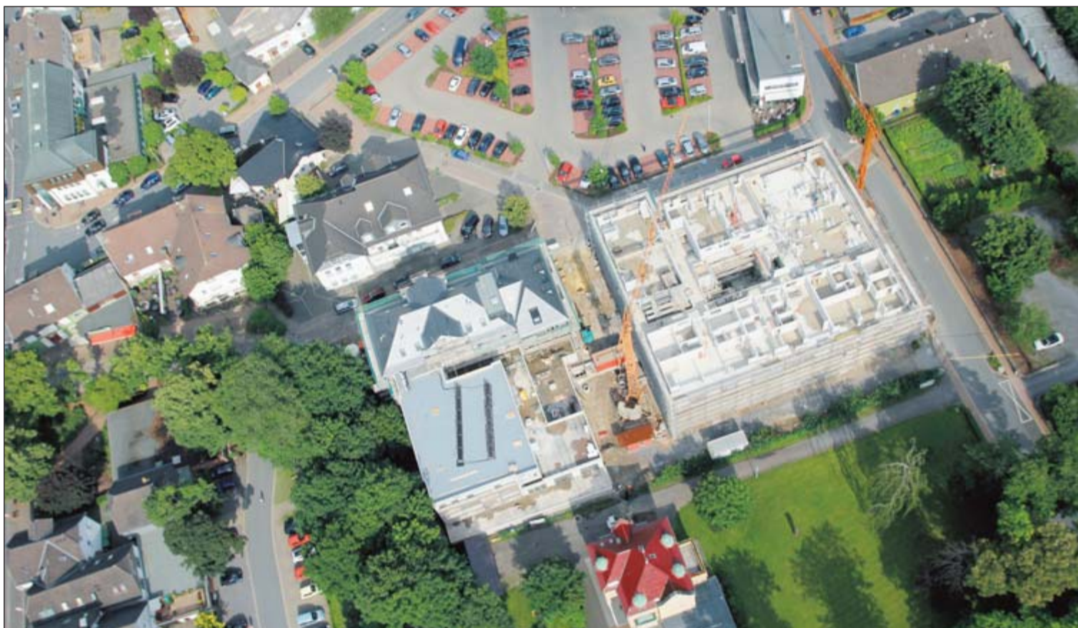
Auf dieser Luftbildaufnahme sind die beeindruckenden Ausmaße des Projektes auf dem ehemaligen Herfeld-Areal erkennbar.
